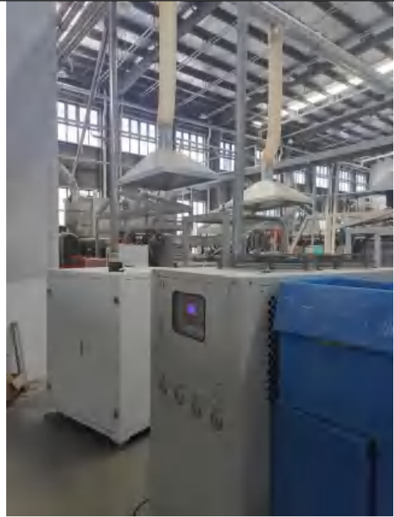
产污设备上方采用集气罩收集
